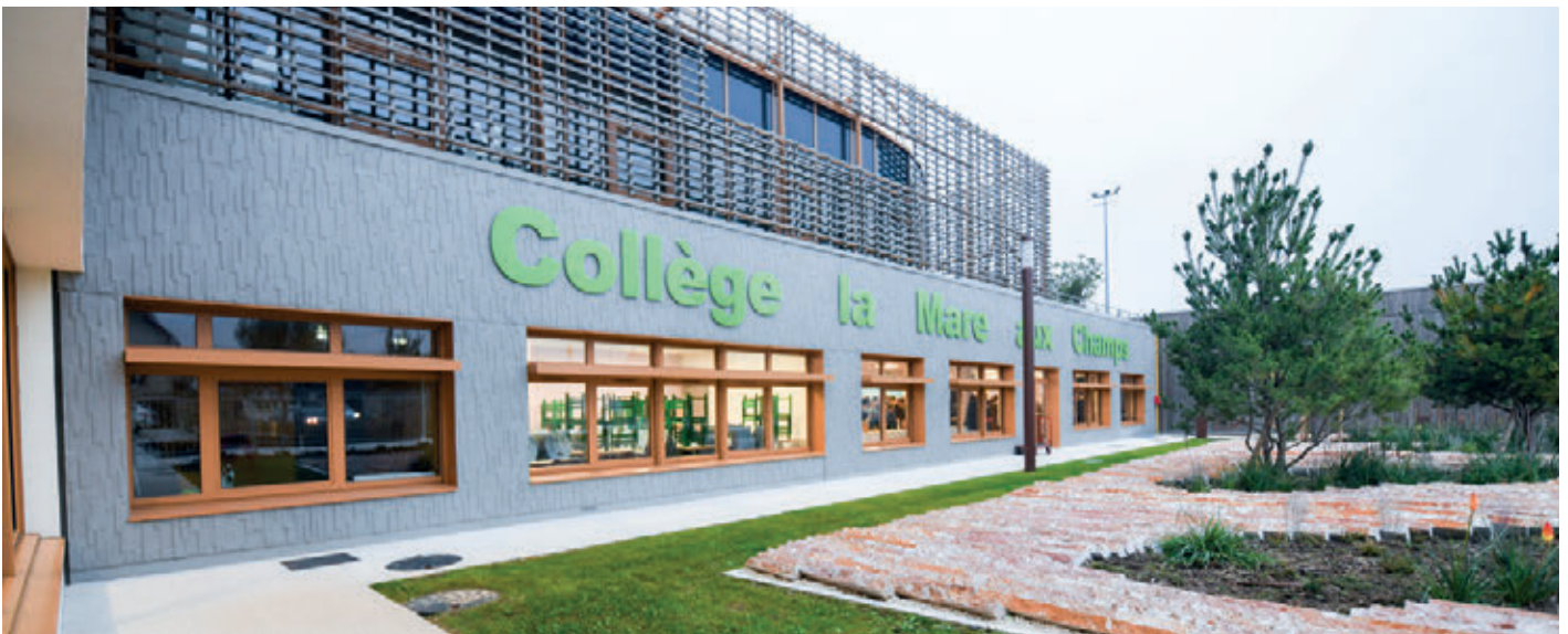
De 2019 à 2022, le collège La Mare-aux-Champs à Vaux-le-Pénil a bénéficié d'une reconstruction partielle et d'une rénovation importante des bâtiments existants.
